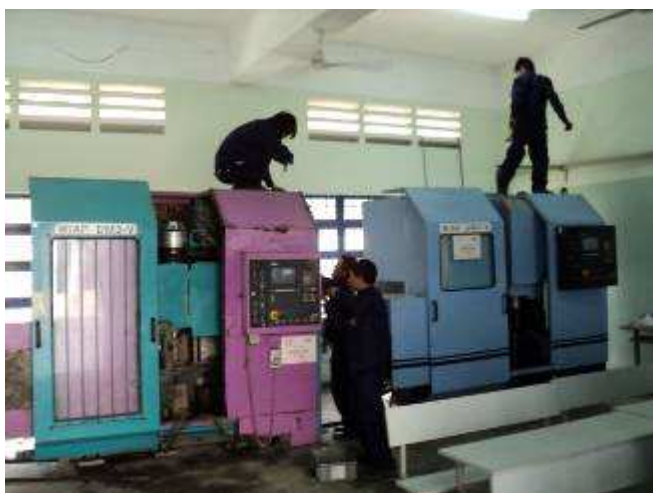
Foto 6. Hier demontiert man den Strom, entfernt das Dach der Maschine, um sie anhängen zu können.
