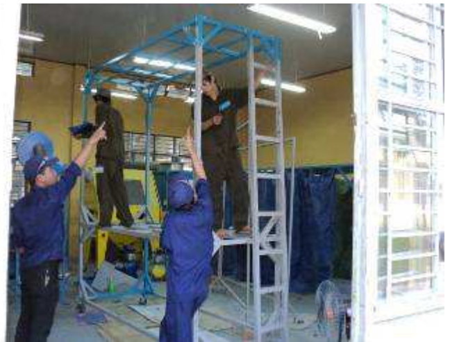
Foto 32: Das Gerüst in der Malerei. Es ist so gross, hat gar kein Platz in der Spritzkabine.
