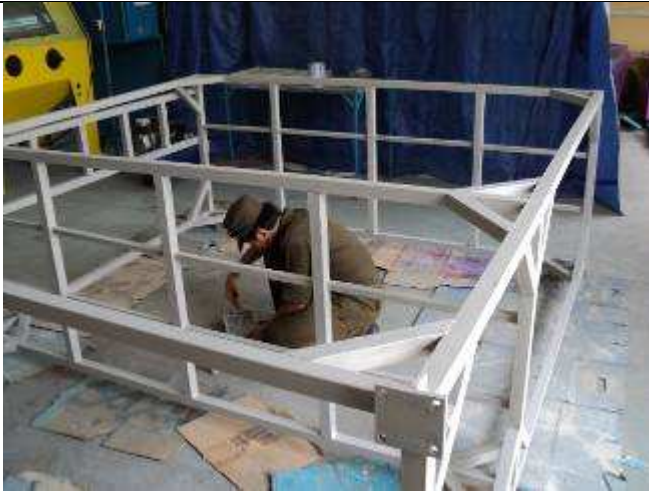
Foto 10: Langsam aber sicher, wird unser Rollgerüst fertig.
