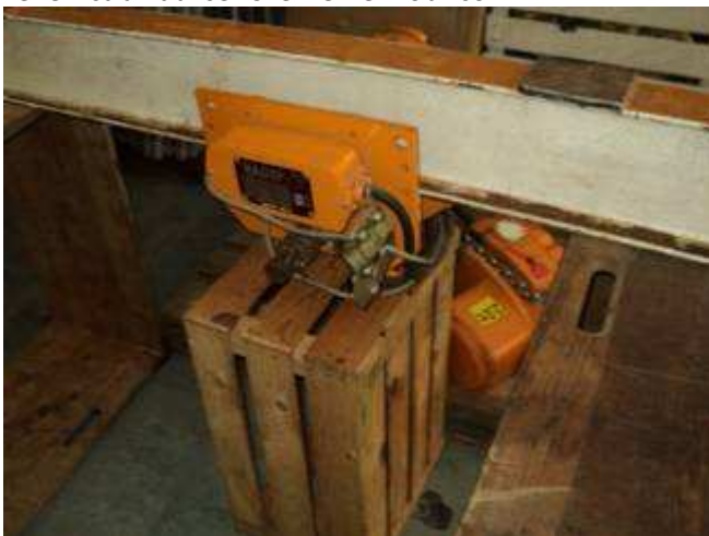
Photo 30. Hier hängen wir den 2 Tonnen Kran auf um Masse abnehmen zu können. Wir werden eine brauchbare, gute Zeichnung machen für den neuen Kran.
