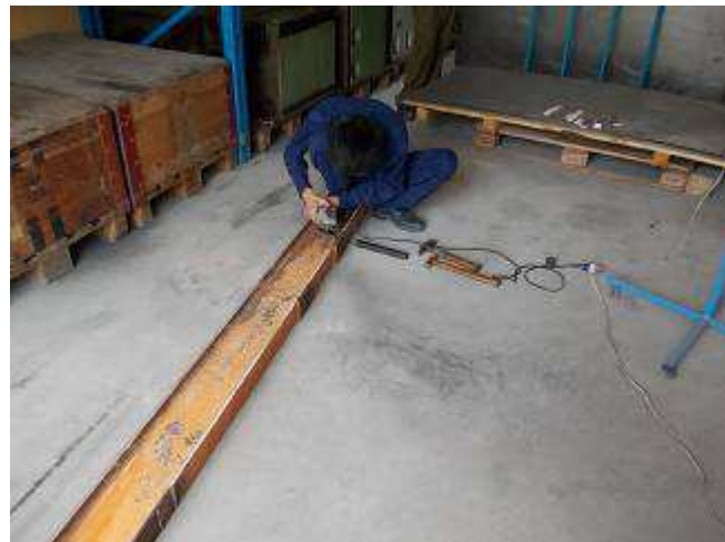
Photo 22: Noch immer haben wir den fahrbaren 2-Tonnen Kran nicht fertig. Unser Wunsch war, wenn wir weg sind, das er gemacht wird. Hier trennt ein Lehrling am Träger noch überflüsse Anschweissungen ab.
