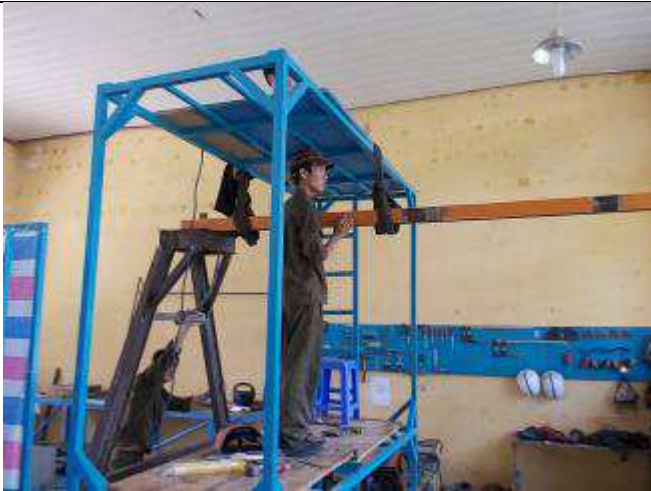
Ảnh 28: Đây là cấu trúc đã được lắp đặt.
