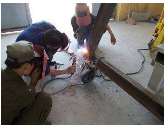
Foto 30: Hier wird noch eine Verstärkung angeschweisst; auch von einem Lehrersupporter.
