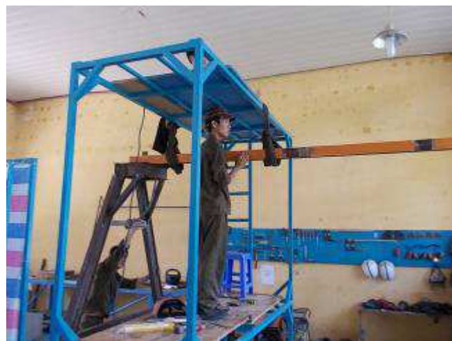
Foto 28: Hier wird der Kran aufgestellt.
