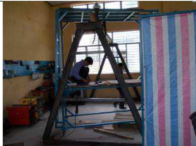
Foto 26: Unser 2 Tonnen Kran: immer noch nicht fertig.
