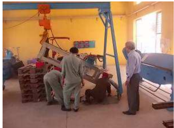
Photo 5: Hier wird Zement eingefüllt und auch vibriert beim Füllen.
