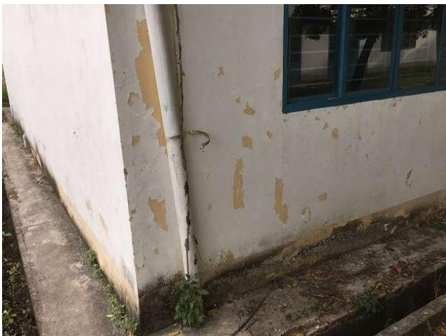
toda a fachada da escola foram repintados cerca de 3 anos. Os custos que temos metade da escola. Por que ver na construção do Vietnã em breve novamente assim? É a qualidade do trabalho? Ou o material? Localização: Exterior 3b espaço. WS10_330 foto
