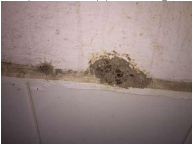
ninhos de vespas no banheiro. Localização: WC atrás do espaço 6. Foto WS10_320
