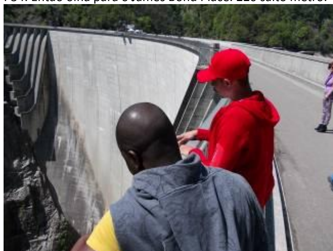
P36 Muito alto muro da barragem Verscasca.
