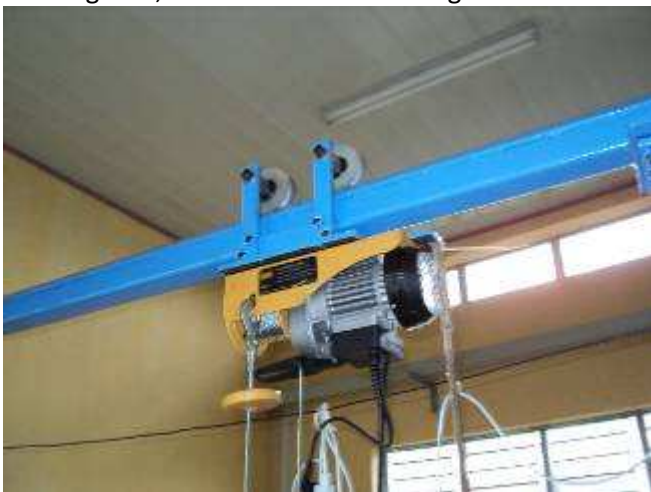
Photo 02: Unser Kran Nummer 02 hat uns jetzt schon viel geholfen, damit wir viel schneller vorwärts kommen. Nach den Ferien machen wir noch 2 schwerere Ausführungen.
