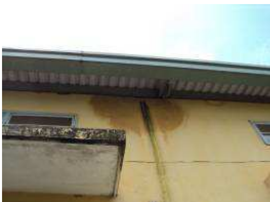
Photo 30. Solche Wasser Löcher werde auch repariert
