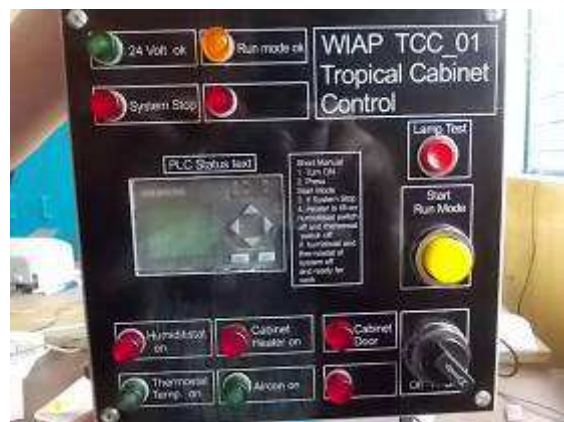
Photo 4: Wir haben 20 Stück Tropical Cabinet Controller begonnen für Angola. Dort zerstört uns das Kondenswasser immer die Elektronik.
