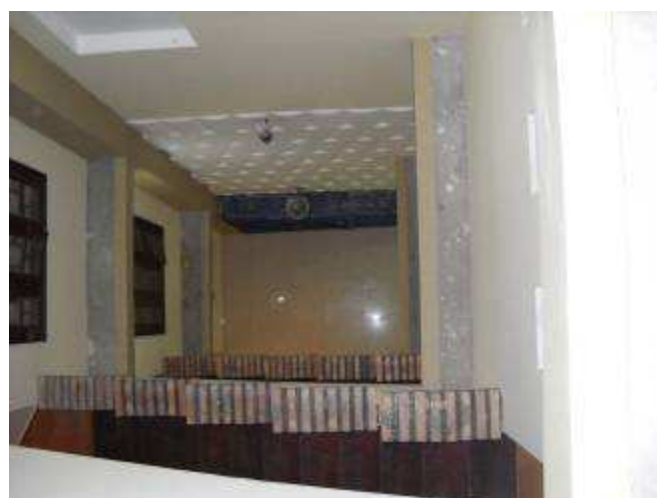
P16: Treppenhaus von unten, das Haus ist hoch
