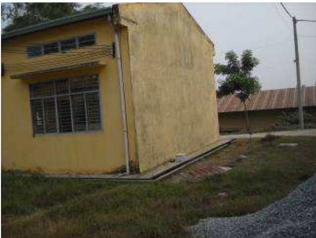
P15: Hier die Halle 1 mit gereinigter Wand
