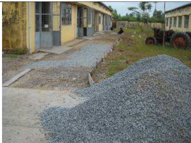
P6. Letzte Woche vorbereitete Strasse, um von der Halle 1a bis 3b zu 4a bis 5b fahren zu können.
